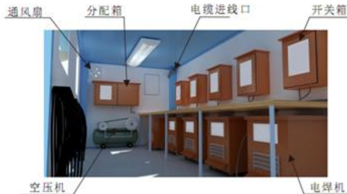
图表 11-3 焊机房内视图
