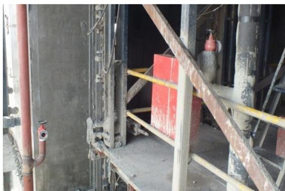
图 4：设置消防立管、水箱等设备
